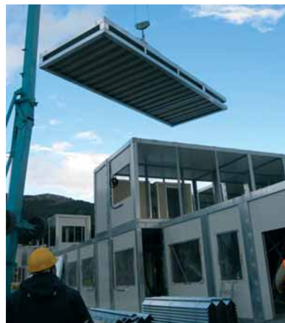
Fig. 26 - Fase di montaggio di sistemi a moduli (L'Aquila)
