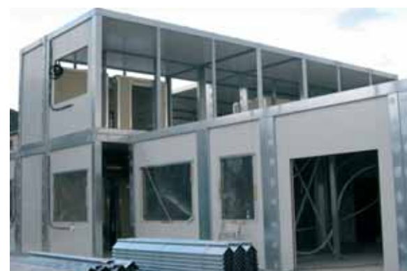
Fig. 25 - Sistemi a moduli in cold-formed (L'Aquila)
