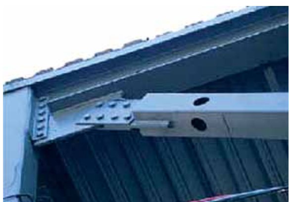
Fig. 22 - Controvento a sezione ridotta (RBS)
