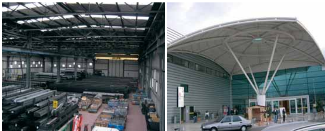
Fig. 7 - Edifici in acciaio dopo il sisma (L'Aquila)
