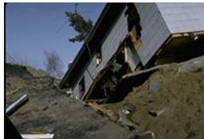
Terremoto di Anchorage, Alaska, 1964
